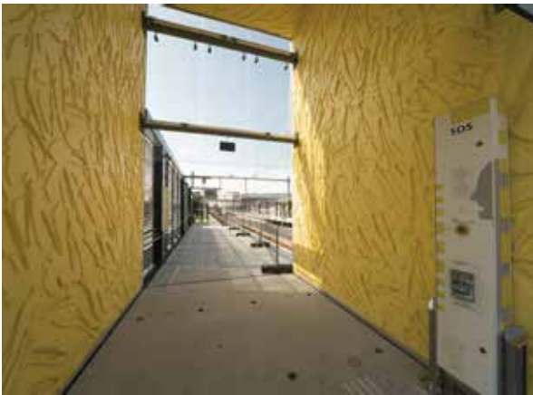
Betongestaltung einer niederländischen U-Bahn-Linie nach Vorlage des Rotterdamer Designers Erik Sandifor
