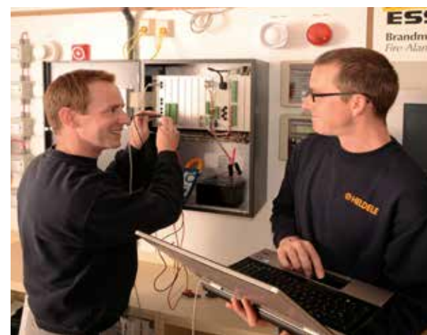
Die Gebäudetechnik, Gebäudeautomation und Sicherheitstechnik sind immer noch die größten Bereiche der Heldele GmbH.
