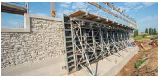
Hochwasserschutzwand aus Beton mit einer dreidimensionalen Optik
