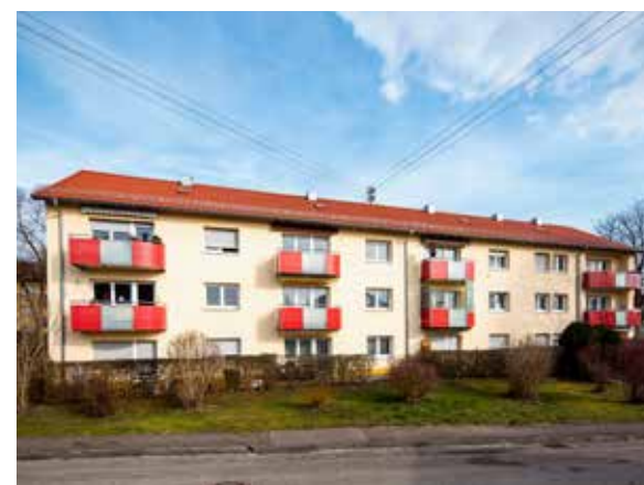
Modernisierte Gebäude „Eisenbahnstraße Uhingen“
