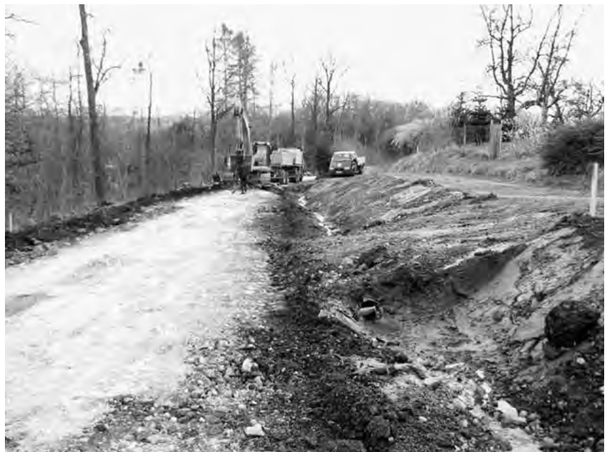
Die Bauarbeiten zum Ausbau der K 1413 Ebersbach – Büchenbronn schreiten voran.
