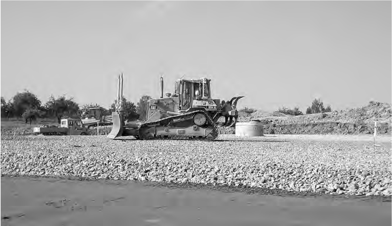
Auf der mineralischen Dichtungsschicht wird die Entwässerungsschicht aufgetragen.
