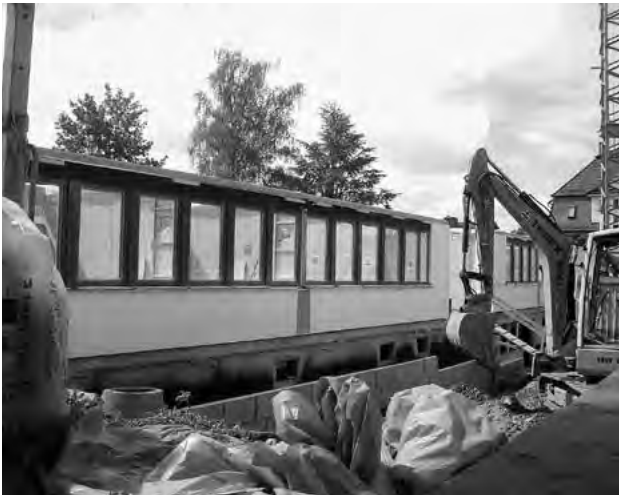
Das Erdgeschoss steht.
