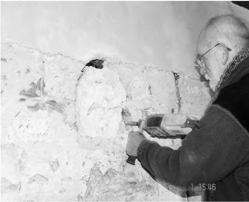
Kuchen: Entdeckung und Freilegung einer zugemauerten Nische mit Spitzbogen in der Jakobuskirche Foto: Kreisarchäologie
