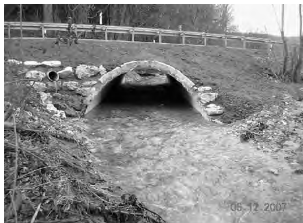
Fertiger Durchlass Hartelbach
