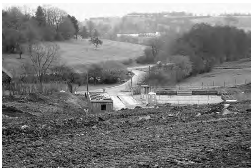
Rückbau nicht mehr benötigter Betriebseinrichtungen – Sedimentationsbecken, Eingangskontrollgebäude
