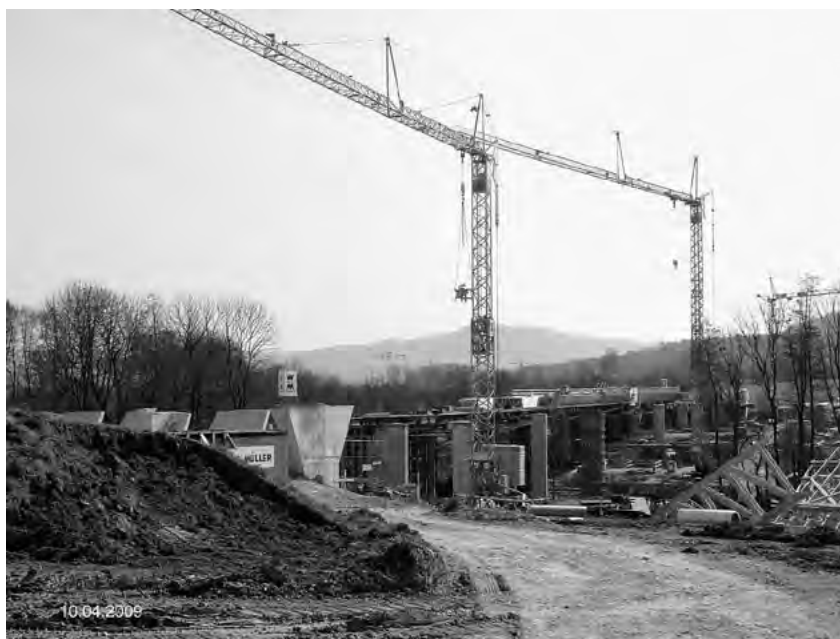
Brücke Baustelle Schlater Straße
