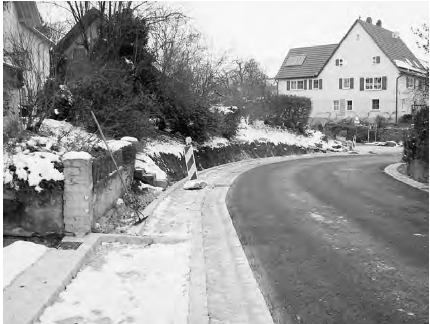
Die neue Fahrbahn der Ortsdurchfahrt Breech ist bereits hergestellt.
