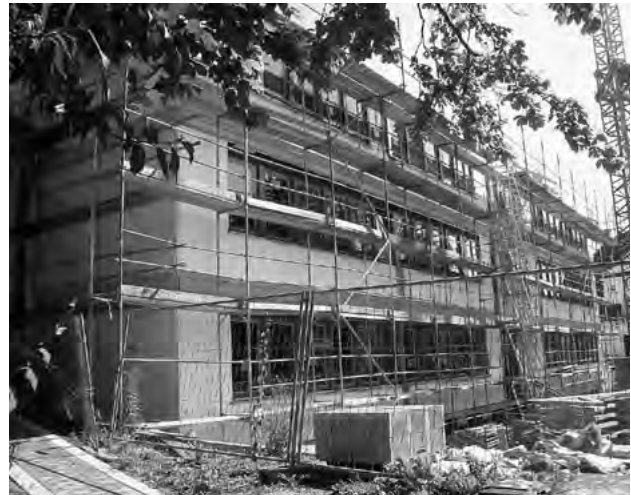
Der Außenputz wird angebracht.
