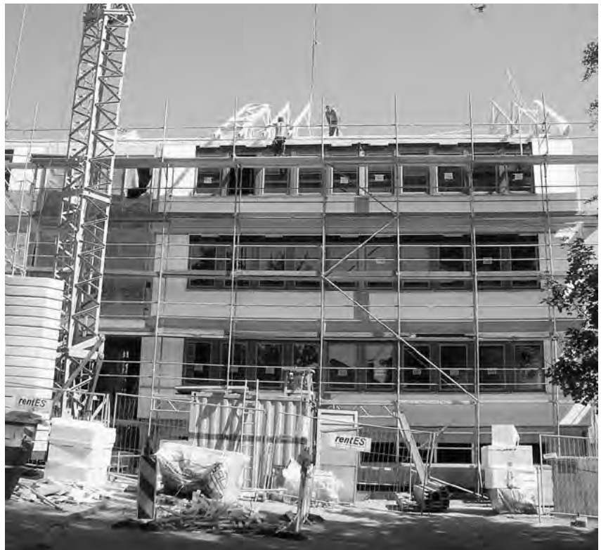
Der Neubau wächst.
