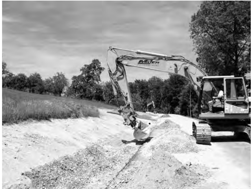
Der Bagger profiliert die Entwässerungsanlage an der K 1413.
