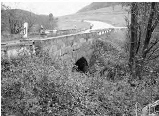
Alte Gewölbebrücke aus Tuffstein – Baujahr 1860
