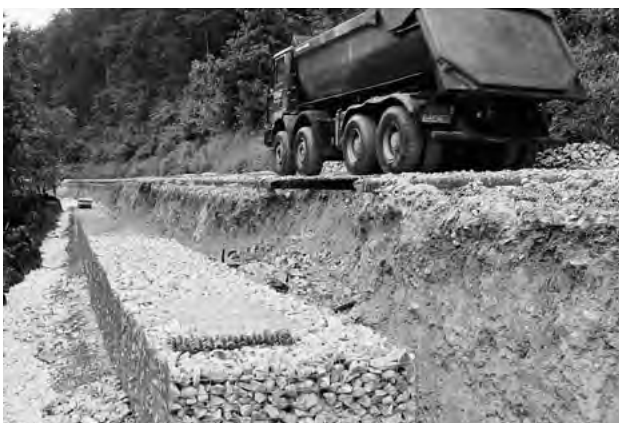
Einbau von Gabionen an der Stöttener Steige
