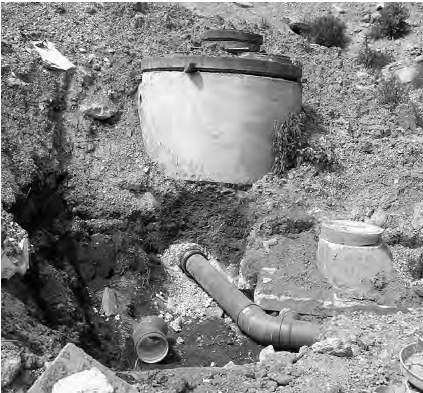
Sanierung des Entwässerungssystems
