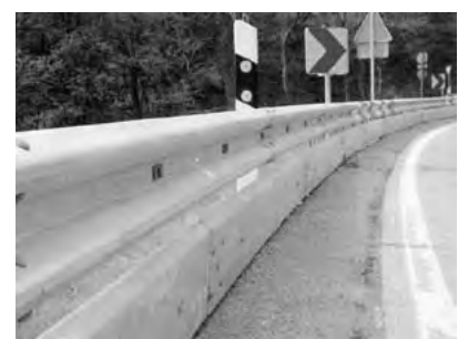
Schutzplanken ohne Unterfahrschutz (links) und mit Unterfahrschutz (rechts unten). Ein solcher Unterfahrschutz kann schwere Verletzungen bei einem Sturz verhindern. Fahrbahnschäden wie Risse oder deren Verfüllung führen häufig zu Stürzen (rechts oben).
