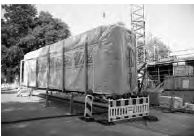
Anlieferung der Großtafeln
