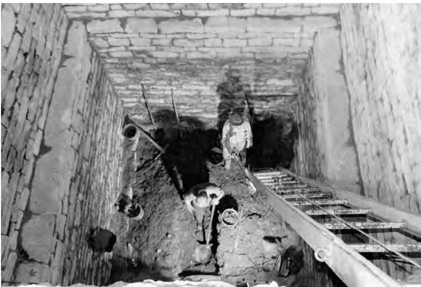
Bad Ditzgenbach: Freilegungsarbeiten im Inneren des südwestlichen Bergfrieds der mittelalterlichen Hiltenburg
