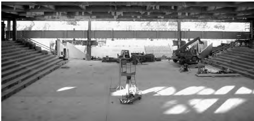
△ Besichtigung der Baustelle der EWS-Arena
