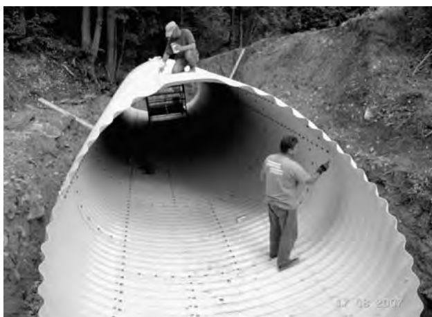
Einbau HAMCO-Stahlwellprofil in die Bachsohle des Hartelbaches
