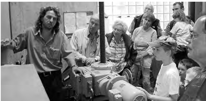
Der Betriebsbeauftragte Markus Bachofer erklärt im Schieberhaus die Funktionsweise der technischen Einrichtungen.
